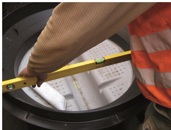
Slika 3 i 4: Kontrola položaja odvoda
