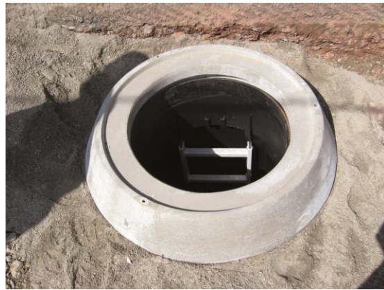
Slika 9 i 10: Postavljanje betonskog prstena za prihvat opterećenja
