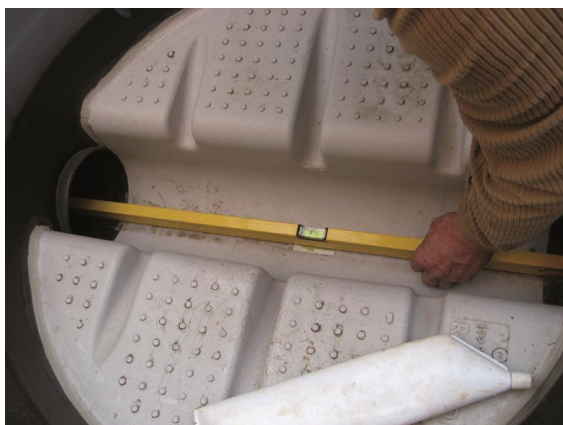
Slika 3 i 4: Kontrola položaja odvoda
