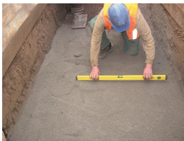
Slika 1 i 2: Priprema podloge za polaganje šahtova
