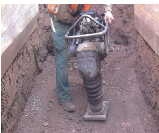
Slika 1 i 2: Priprema podloge za polaganje šahtova
